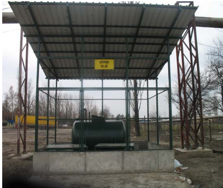
Slika 16. Skladište otpadnog ulja sa tankvanom
