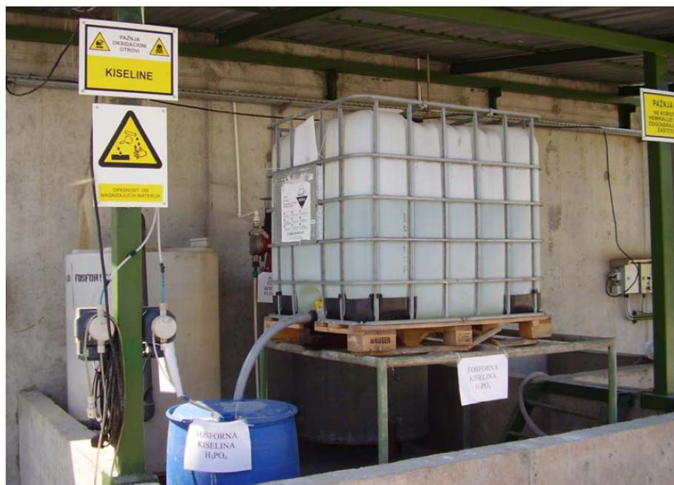
Slika 13. Rezervoar sa fosfornom kiselinom
