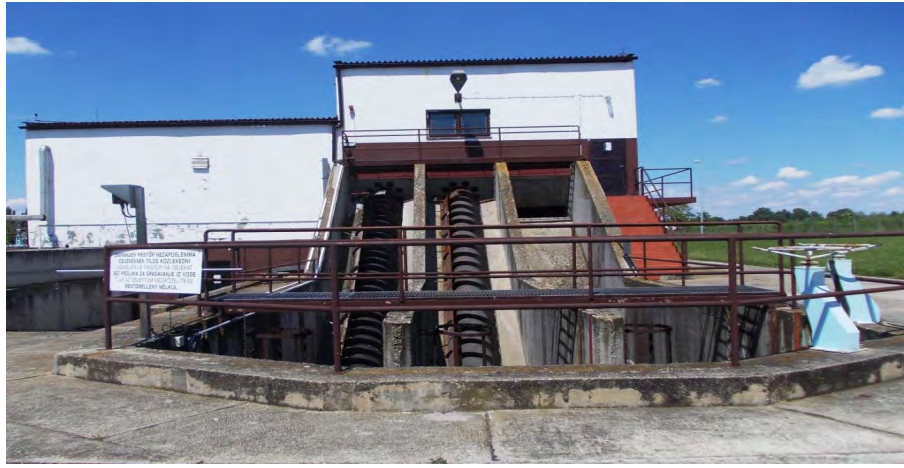
Csigaszivattyús szivattyúállomás
