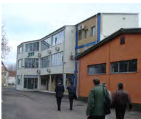
Фабрички комплекс JT International А.Д. Сента
