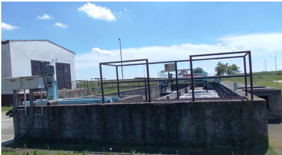
Песколов са сепаратором масноће
